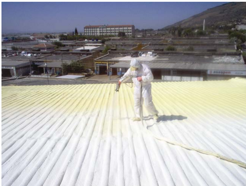
Polaganje tekuće membrane špricanjem
