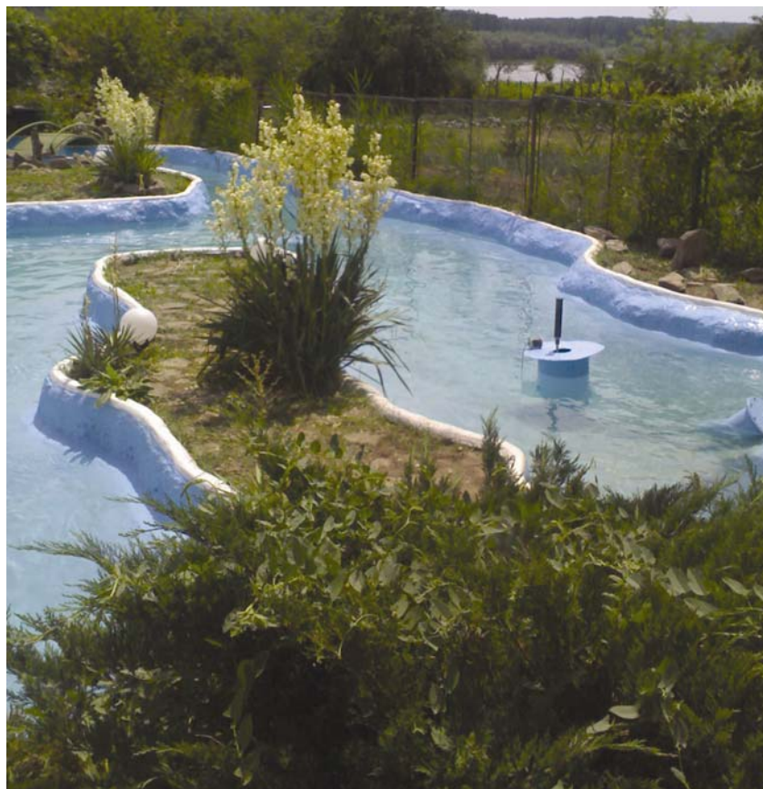
Prozirni hidroizolacijski premaz preko plave podloge bazena
