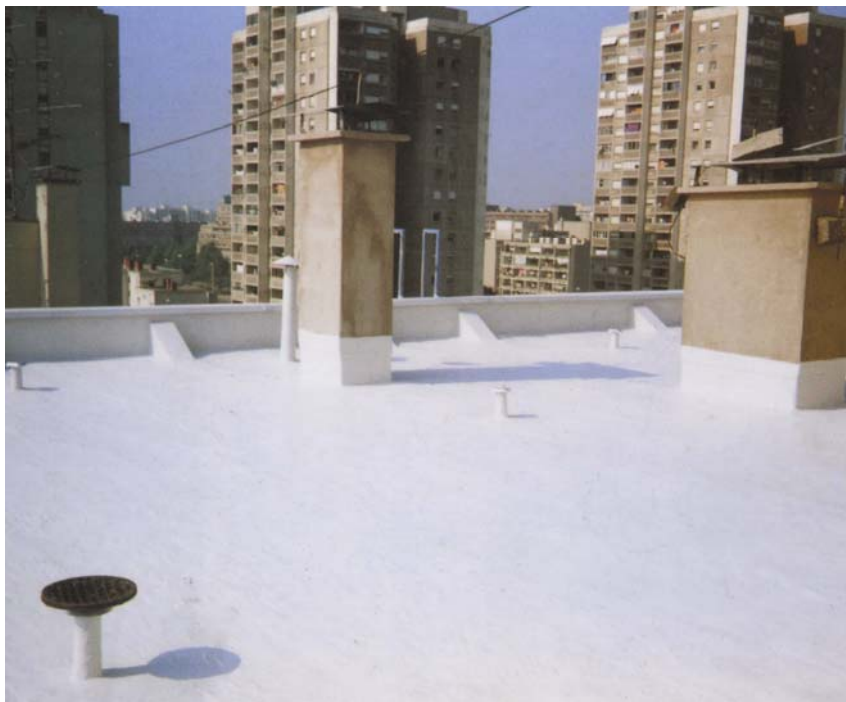
Krov izoliran tekućom membranom
